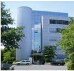
Das CardProcess Gebäude in Ettlingen
